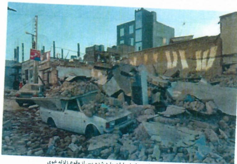
شکل (۱) - تصاویری از خسارات وارد شده پس از وقوع زلزله خوی
