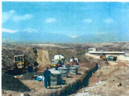
شکل (۲۲) - تصاویری از میزان پیشرفت پروژه تأمین اسکان موقت برای زلزله‌زدگان منطقه خوی
