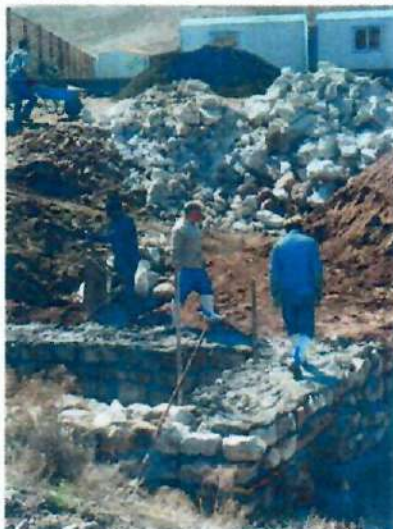
شکل (۲۱) - تصاویری از میزان پیشرفت پروژه تأمین اسکان موقت برای زلزله‌زدگان منطقه خوی
