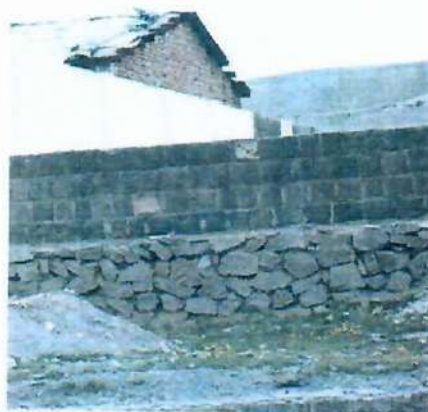
شکل (۱۰) - تصاویری از میزان پیشرفت پروژه تأمین اسکان موقت برای زلزله‌زدگان منطقه خوی
