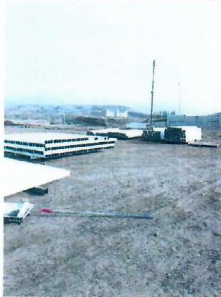
شکل (۹) - تصاویری از میزان پیشرفت پروژه تأمین اسکان موقت برای زلزله‌زدگان منطقه خوی
