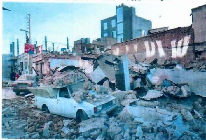
شکل (۱) - تصاویری از خسارات وارد شده پس از وقوع زلزله خوی
